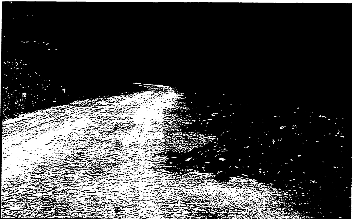
Photo 8. Col de Phi Lieng. Travaux d'amélioration de la route (Lam Ha).
